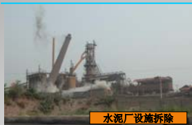
水泥厂设施拆除
